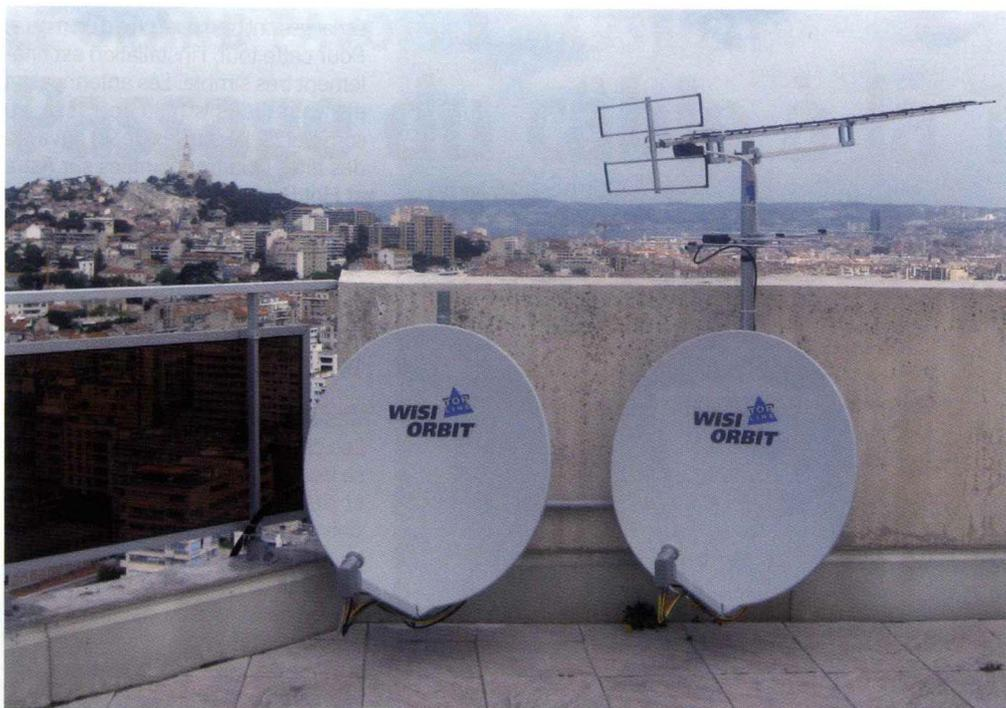
▲ Deux paraboles de 90 cm pointées sur Astra et Hot Bird
