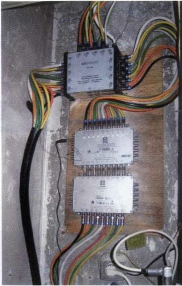
Le haut d'une des deux gaines techniques avec un répartiteur d'où sort un jeu de câbles vers les premiers ampli-commutateurs en cascade entre le 30<sup>ème</sup> et 16<sup>ème</sup> étages, puis vers le 15<sup>ème</sup> (le câble noir) pour alimenter les 15 premiers étages.
